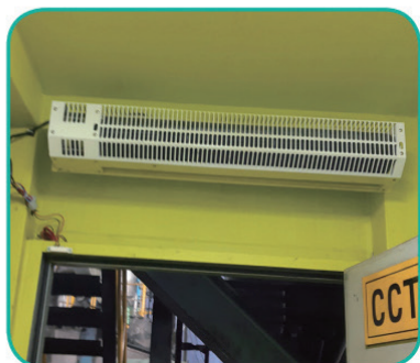
东海火力发电总部 空气门帘
